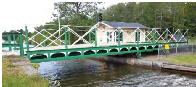
Kanalbron vid Gastorp. Den nya gång- och cykelbron vid Kanalparken kommer att utformas på samma sätt.
