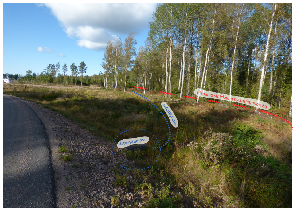
Befintligt dike i planområdets södra del
