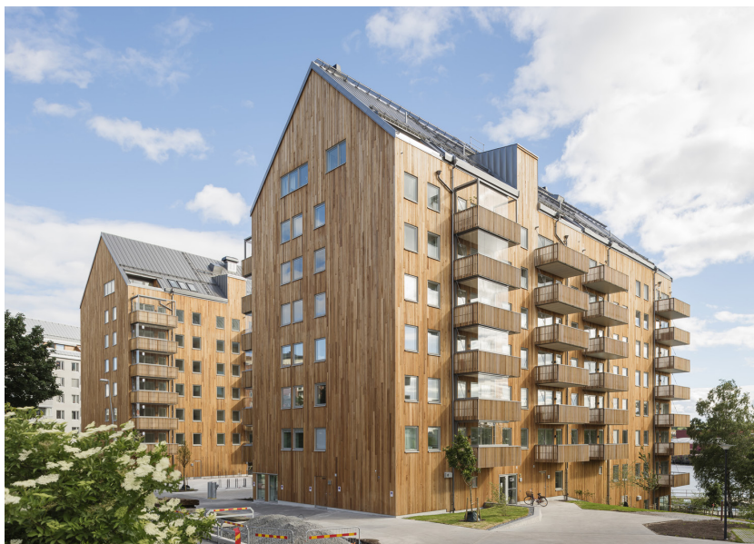
Brf. Bällstaån, Sundbyberg. Origo Arkitekter. Flerbostadshus med fasad i cederträ.
