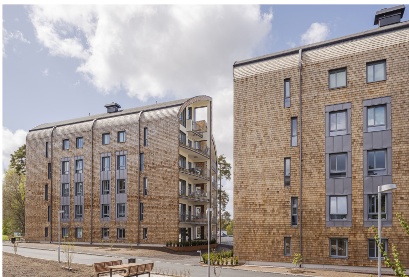
Åsbovägen, Fristad. Tengbom arkitekter. Hyresbostäder i massivträ.
